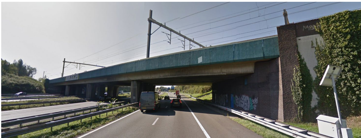
Figuur 21: Spoorwegbrug 'Nieuwe Houtenseweg', huidig profiel A27, rijrichting A27 Breda (Bron: GoogleMaps)
