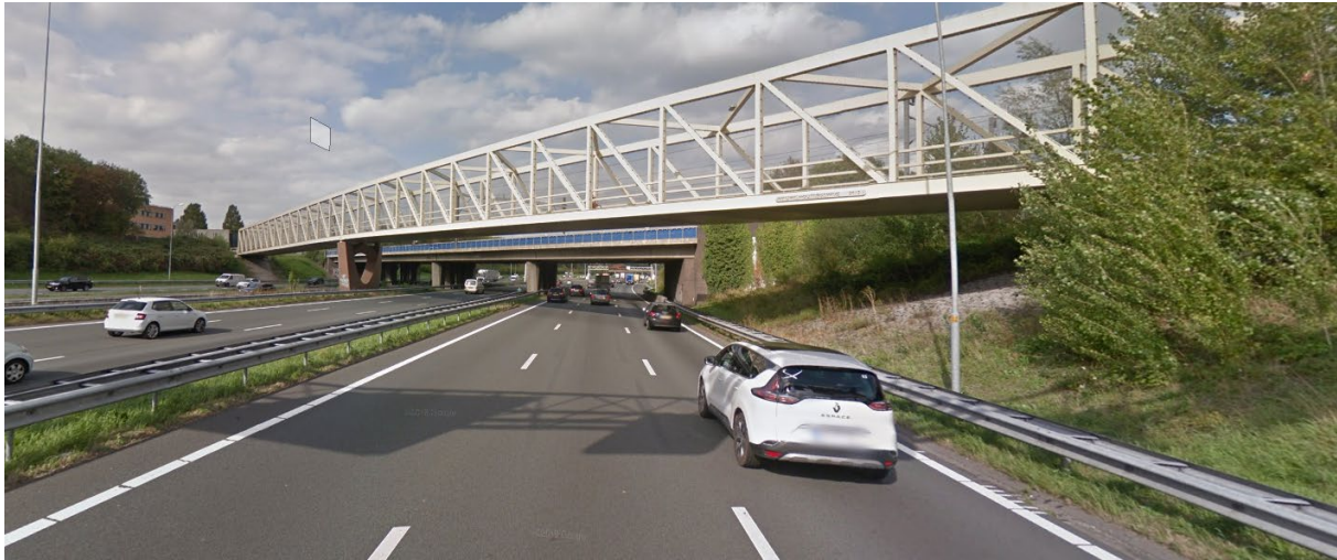
Figuur 20: Spoorwegbrug en brug 'Nieuwe Houtenseweg', huidig profiel A27, rijrichting A27 Hilversum (Bron: GoogleMaps)
