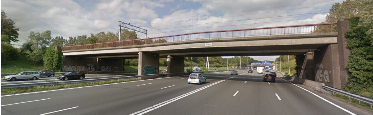
Figuur 16: Spoorwegbrug 'Tussen de Rails' KW16, huidig profiel A27 (Bron: GoogleMaps)
